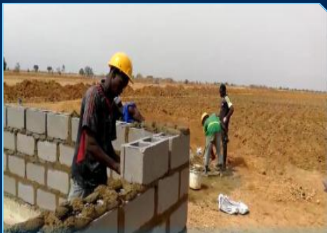
尼日利亚甘蔗园滴灌项目建设 إنشاء مشروع الري بالتنقيط لمزارع قصب السكر في نيجيريا
